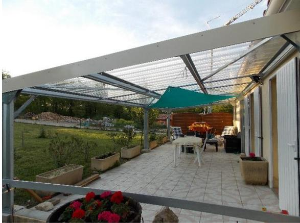
La **plaque polycarbonate translucide** est une solution conçue pour l'éclairage naturel dans les couvertures et bardages offrant une excellente transmission lumineuse, une bonne résistance aux chocs et une réaction au feu optimale.
